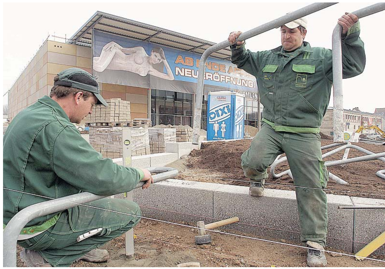
Offensichtlich wenig beeindruckt vom Saturn-Transparent sind diese Arbeiter, die derzeit mit der Gestaltung des Vorplatzes am künftigen Elektromarkt beschäftigt sind. Foto: Hans-Joachim Winckler
